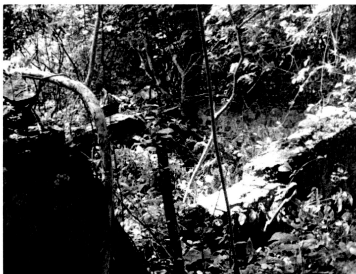
Imágenes 13 y 14 (superior e inferior respectivamente). Se muestra parte de los muros y paredes de las pilas del obraje de añil del tipo "Real", del sitio El Marquesado II, San Vicente.
