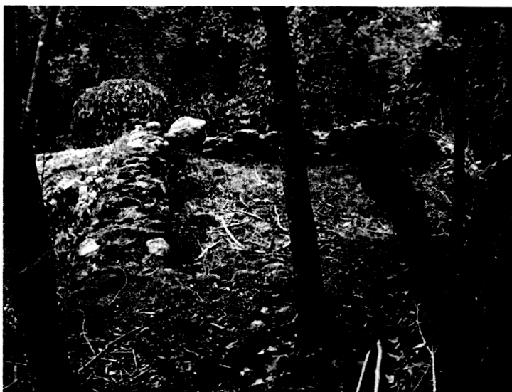
Imágenes 3 y 4 (superior e inferior respectivamente). Se muestra parte de los muros y paredes de las pilas del obraje de añil 2, del tipo "Real", del sitio Achichilco I, San Vicente.
