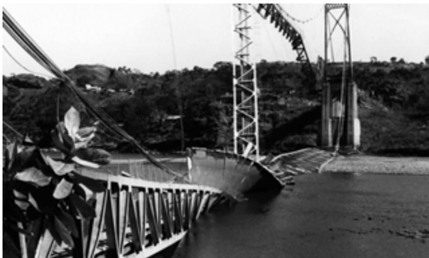
Foto Archivo EDH que muestra la destrucción del puente Cuscullán , ubicado en el kilómetro 70 sobre la carretera Panamericana (01 de enero de 1984).
