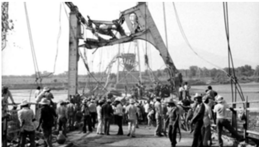
Foto archivo EDH , que muestra la destrucción del Puente de Oro , que causo incomunicación con el oriente del país.
