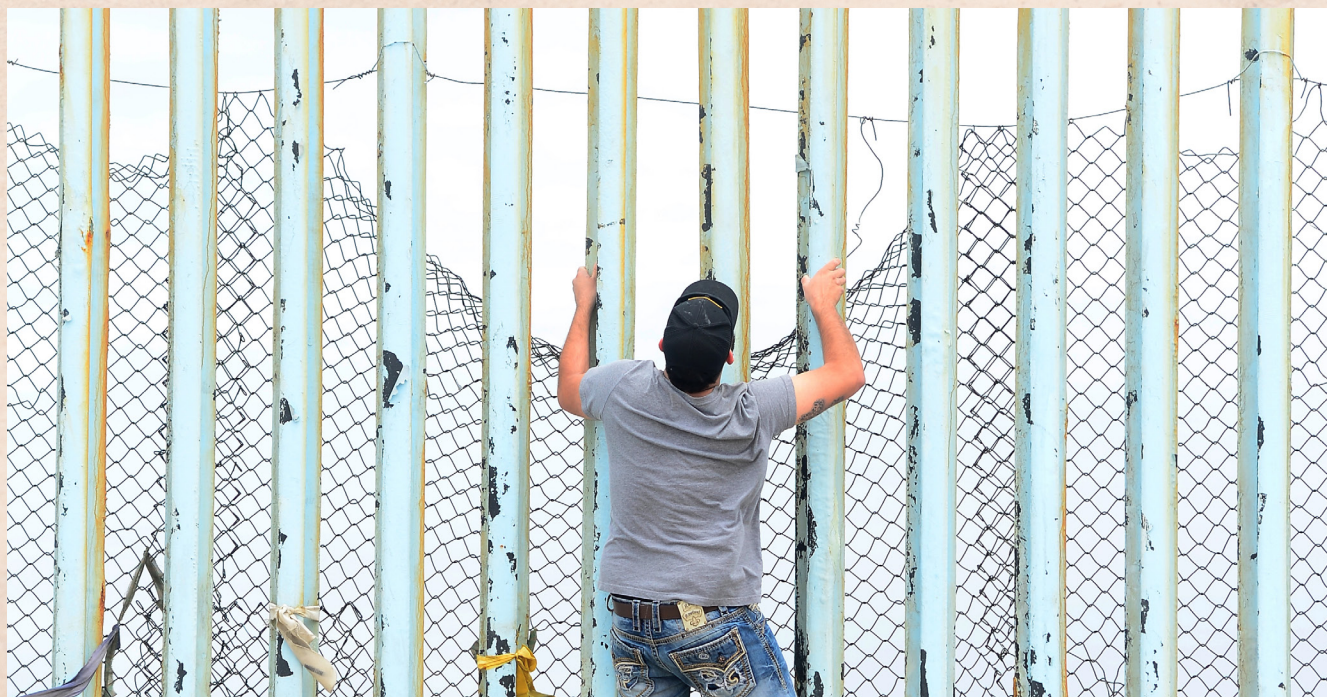
Muro viejo de Tijuana, zona donde se cruzaban los inmigrantes. Actualmente este muro se pudrió y se construyó otro. Fotografía de Mauricio Cáceres
