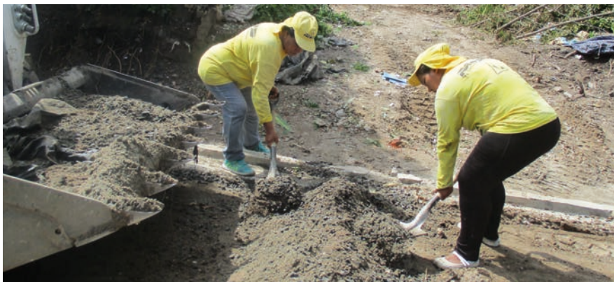
Fotografía tomada en visita de campo realizada el día 26 de septiembre de 2016.
