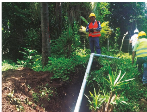
Fotografía tomada en visita al proyecto el 23 de septiembre de 2016.
