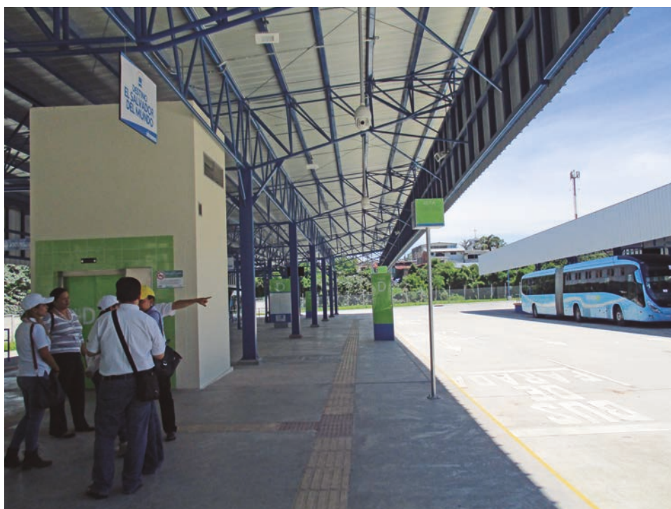
Fotografía tomada en visita de campo realizada el día 19 de septiembre de 2016.
