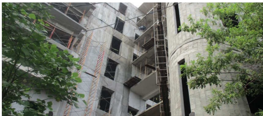
Fotografía tomada en visita de campo realizada el día 27 de septiembre de 2016.
