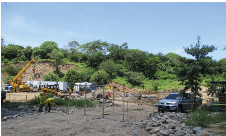
Fotografía tomada en visita de campo realizada el día 21 de septiembre de 2016.
