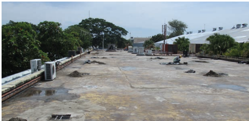
Fotografía tomada en visita al proyecto el 16 de septiembre de 2016.
