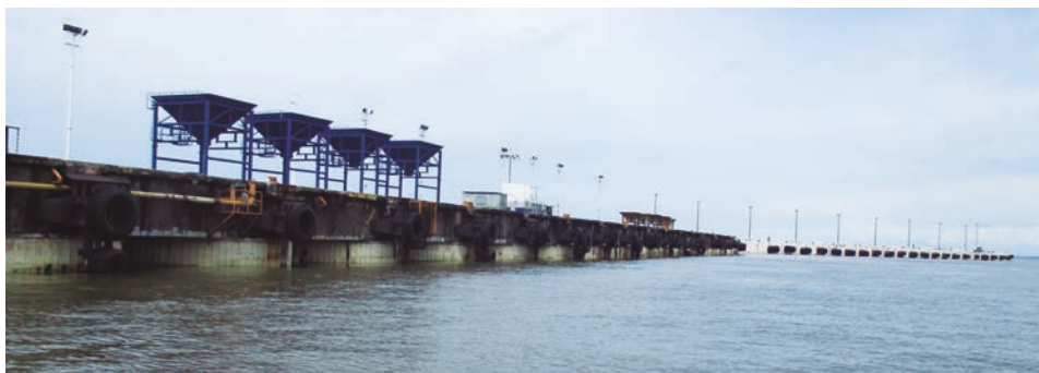
Fotografía tomada en visita al proyecto el 13 de septiembre de 2016.
