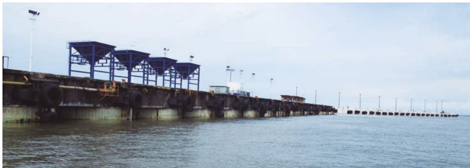
Fotografía tomada en visita al proyecto el 13 de septiembre de 2016.
