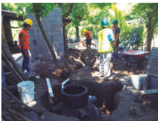
Fotografía tomada en visita al proyecto el 29 de septiembre de 2016.
