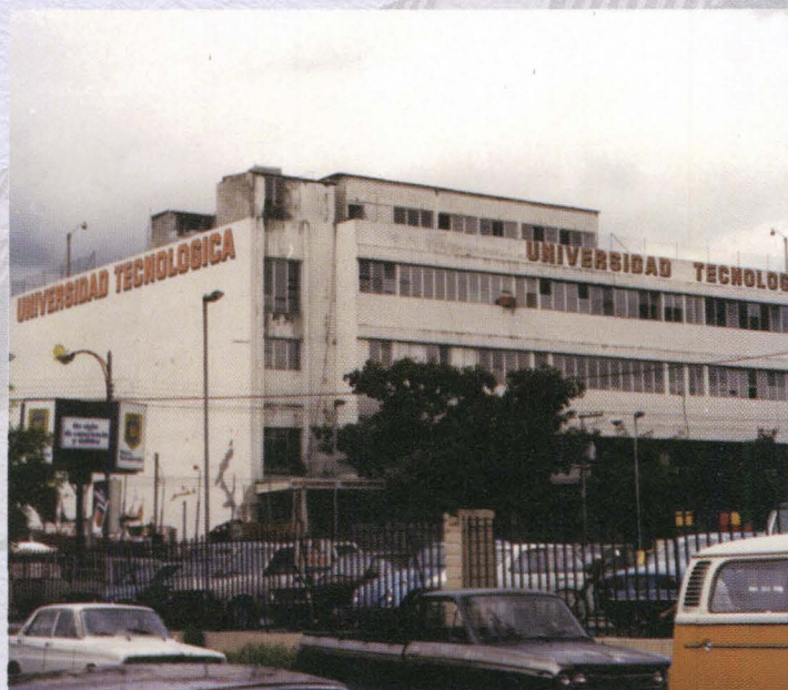
Edificio Chahín, ubicado en la calle Rubén Darío en la capital.
