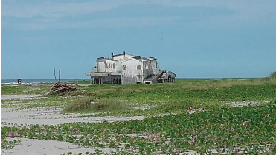
Figura 43. Vivienda construida en una zona erosionada de la playa El Cordoncillo, San Luis La Herradura
