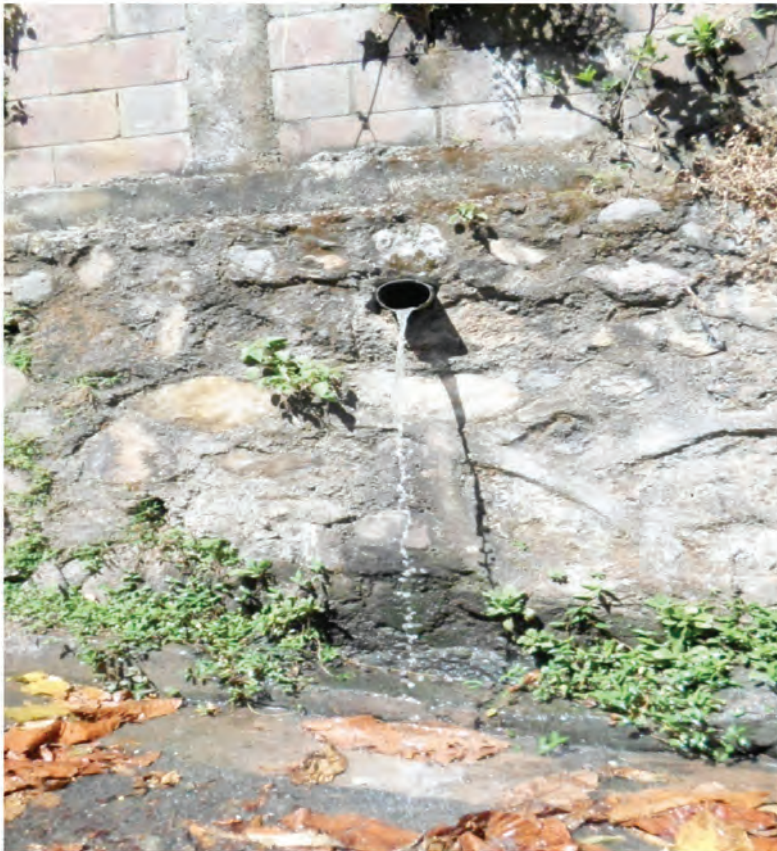
Fotografía. Municipio de San Juan Tepezontes, departamento de La Paz. Se observa que las aguas grises son tiradas a la cuneta sin previo tratamiento. (Sánchez, A. 2016)
