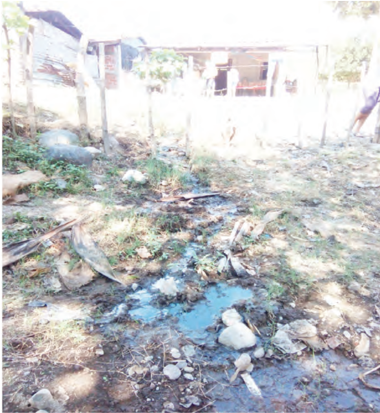
Fotografía. Municipio de El Rosario, departamento de La Paz. Se observa percolación de aguas grises en las cercanías del río Jiboa; al fondo, casa con sistema de letrina de hoyo común. (Sánchez, A. 2016)
