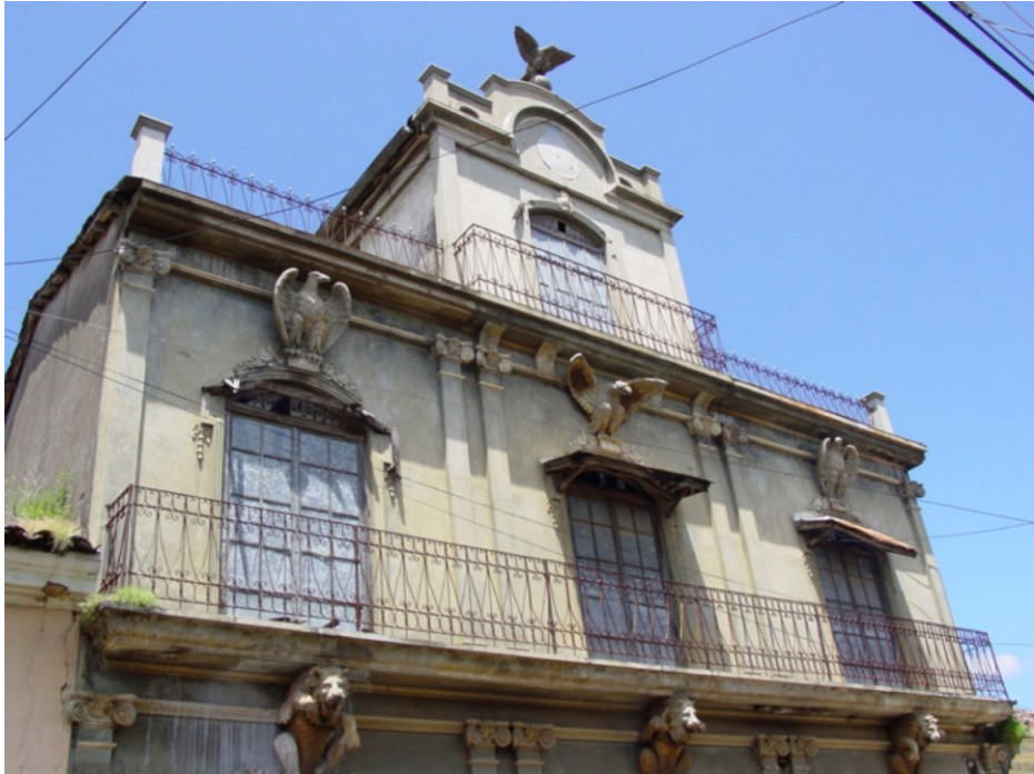
Figura 3. Vista de la “Casa de los Leones”, en el centro histórico de la ciudad de Chalchuapa. Fotografía: Heriberto Erquicia, 2011.
