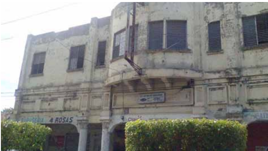
Figura 73. Edificio antiguo del cine
