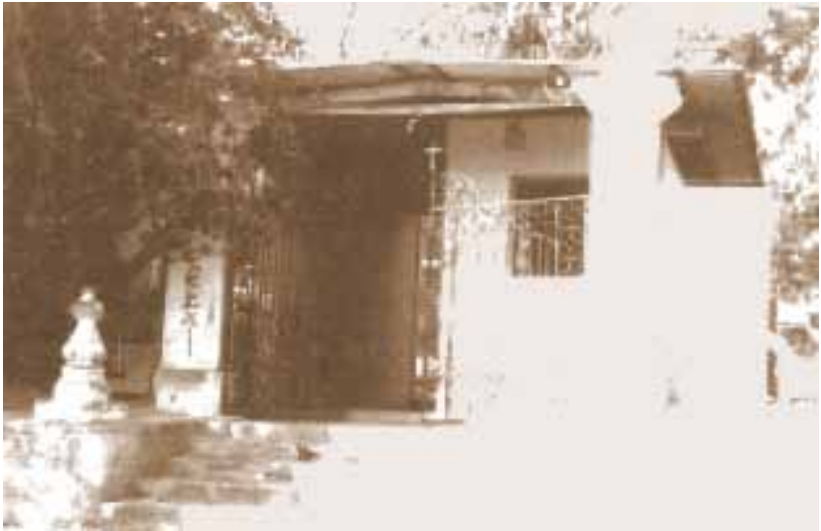
Entrada principal del cementerio de los ricos. Año, 1995.
