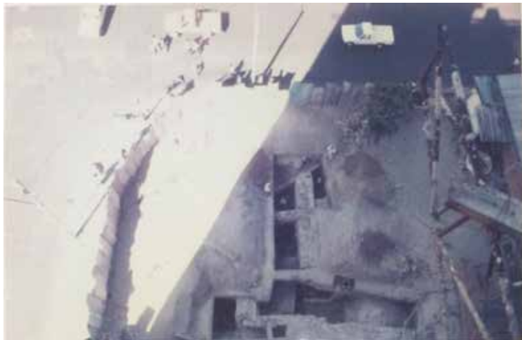
Fig. 5. a) Excavaciones en la esquina de la 2. a Calle poniente y la Avenida España/Cuscatlán, Catedral Metropolitana de San Salvador.
