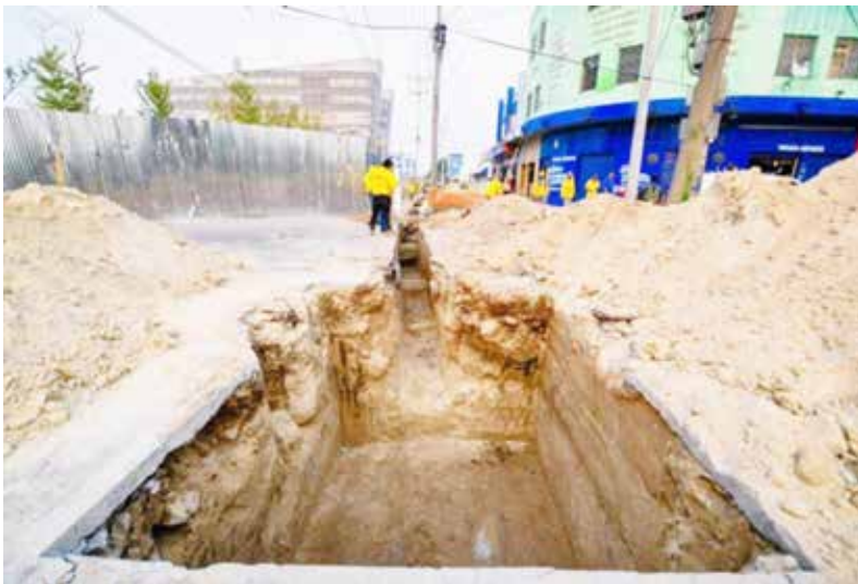
Fig. 3. Detalle donde se observan nivelación de pisos del Periodo Clásico Tardío durante las obras de introducción de cableado subterráneo en la esquina de la 6. a Calle Ote. y la
